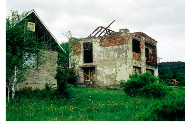
Photographie de maisons détruites à Lička Jesnica, en Croatie, lors de la guerre d'indépendance. Vraisemblablement, les habitants faisaient partie du mauvais groupe ethnique.
